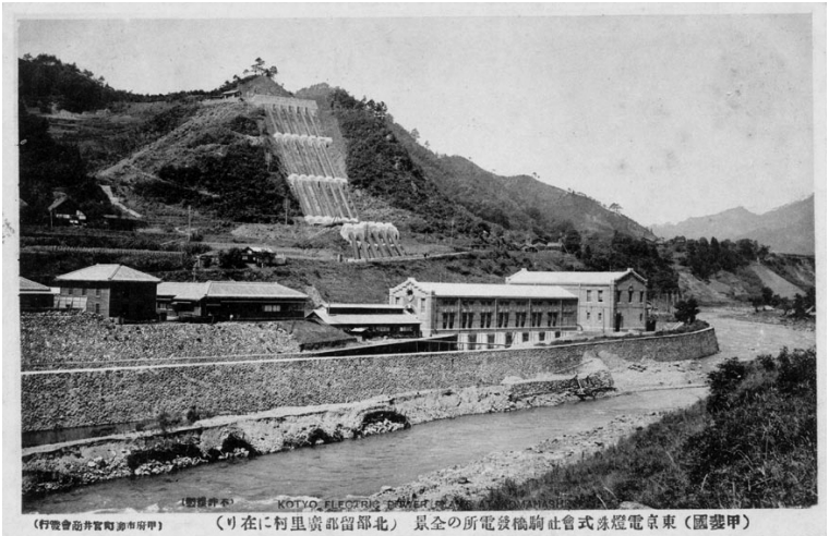
写真3 相模川水系桂川にできた東京電灯（株）の駒橋発電所 (行燈會館并官町 池市甲府) (り在に村里黄那留郡北) 景全の所電設機駒止會式泳燈電京東(國斐甲)
