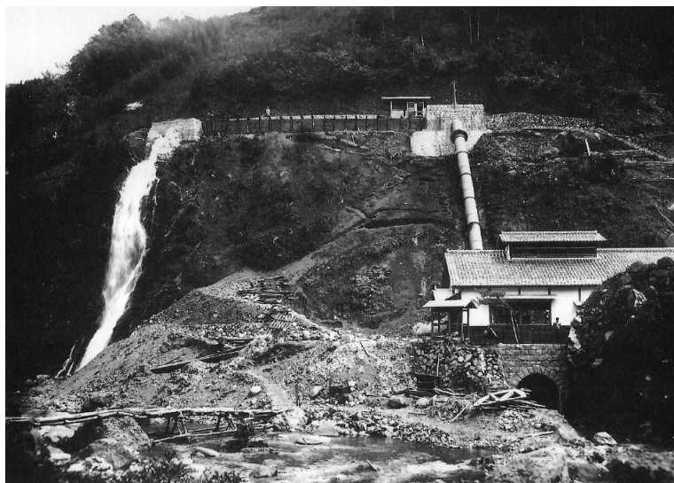
写真1 富士川水系芦川に設置された竣工直前の芦川第一発電所 出典：写真集山梨百年（1989）山梨日日新聞社、甲府
